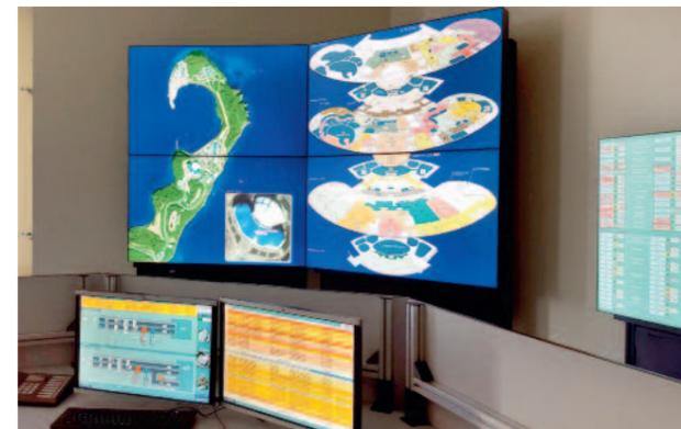
**Рис. 3. Диспетчерская океанариума с дельфинарием. АРМ и СОИ старшего диспетчера**
